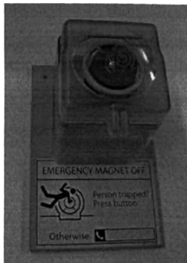
Рис. 2: Кнопка экстренного выключения магнита с соответствующей этикеткой.
