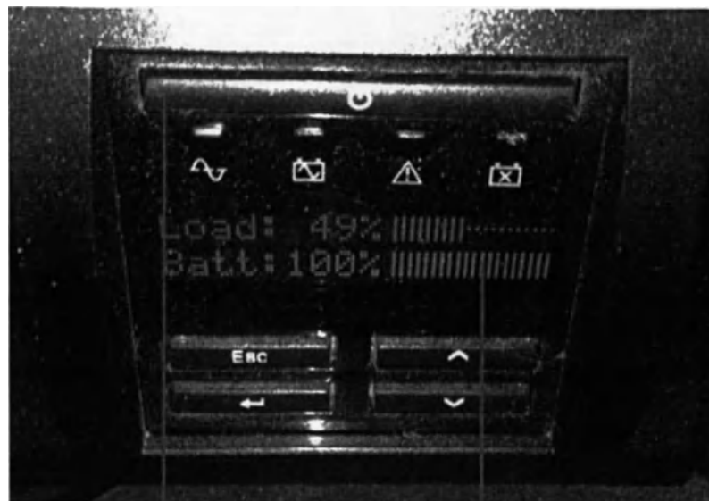
Выключатель питания UPS
