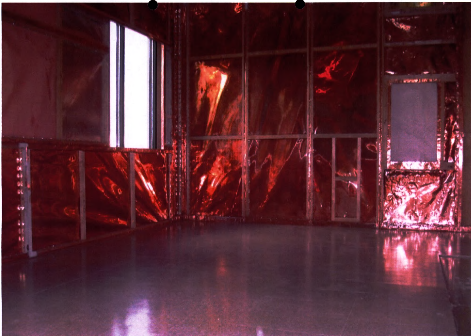
Устройство для защитного экранирования помещения (Клетка Фарадея).
