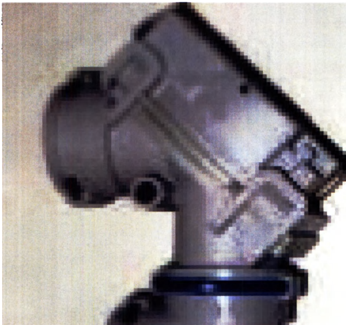
10. Клапан электропневматический для сухой линии;
