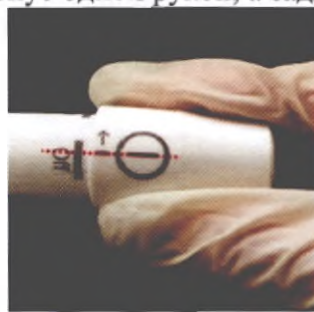
Рисунок 18: Совмещение меток "ON/OFF" (ВКЛ./ВЫКЛ.)
