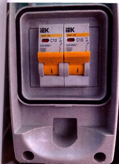
Рис. 46 Автоматические выключатели
