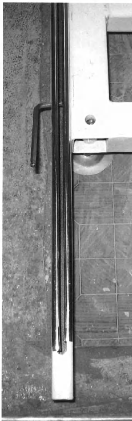
Рисунок Б.4. Установка нижней направляющей двери.
