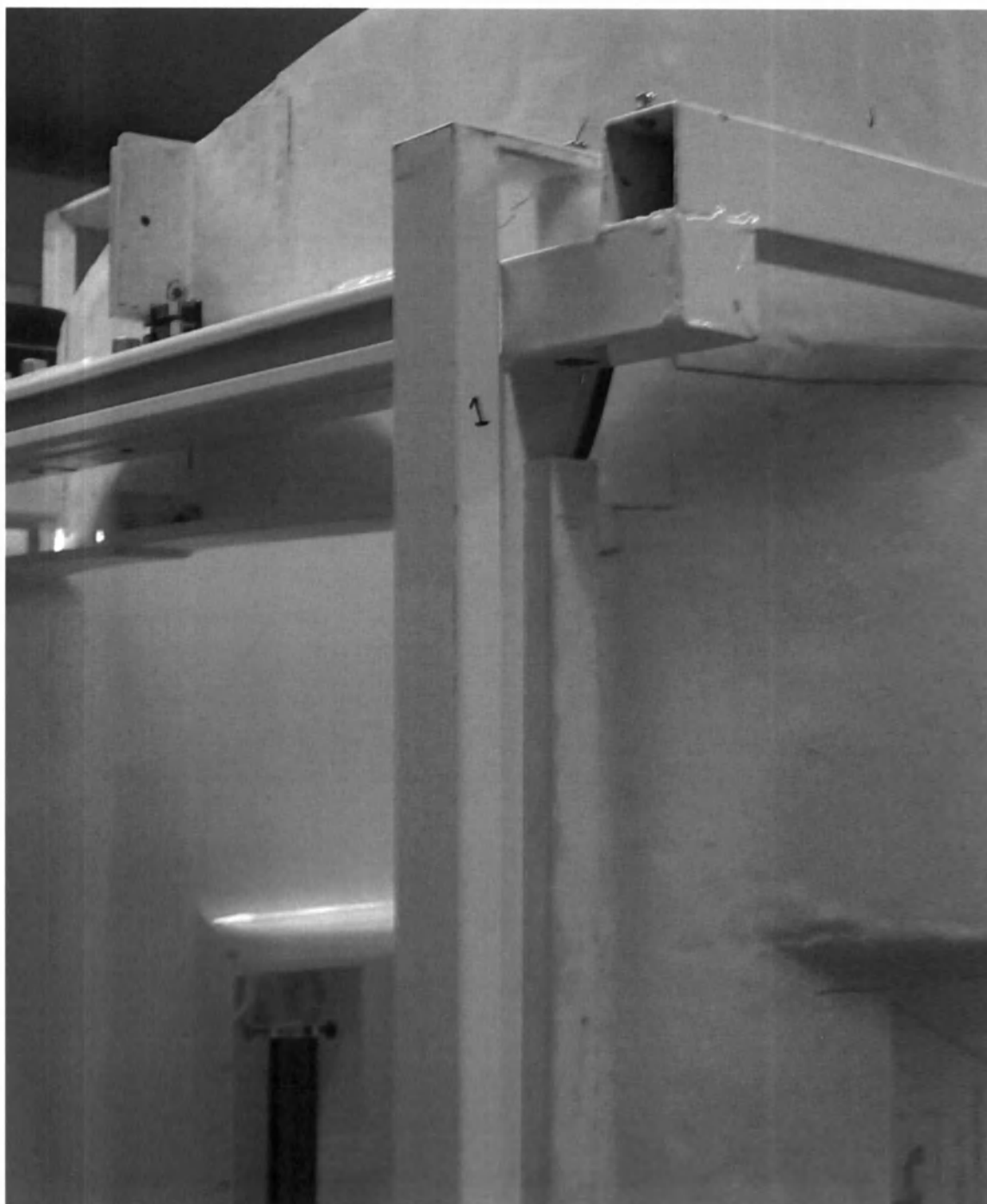
Рисунок Б.5. Установка опор декоративного кожуха.
