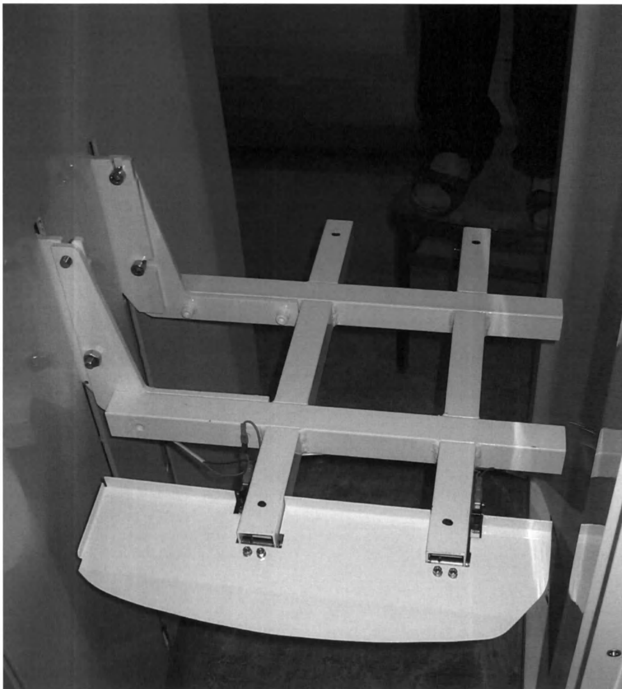
Рисунок Б.9. Установка рамы площадки подъемника.
