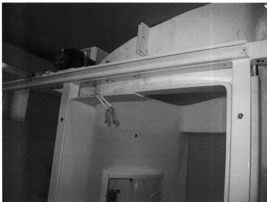
Рисунок Б.3. Установка верхней направляющей двери.
