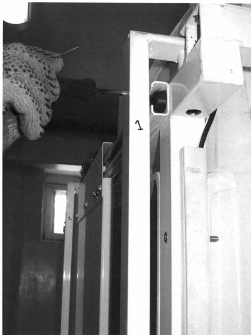
Рисунок Б.7. Установка отбойника двери.
