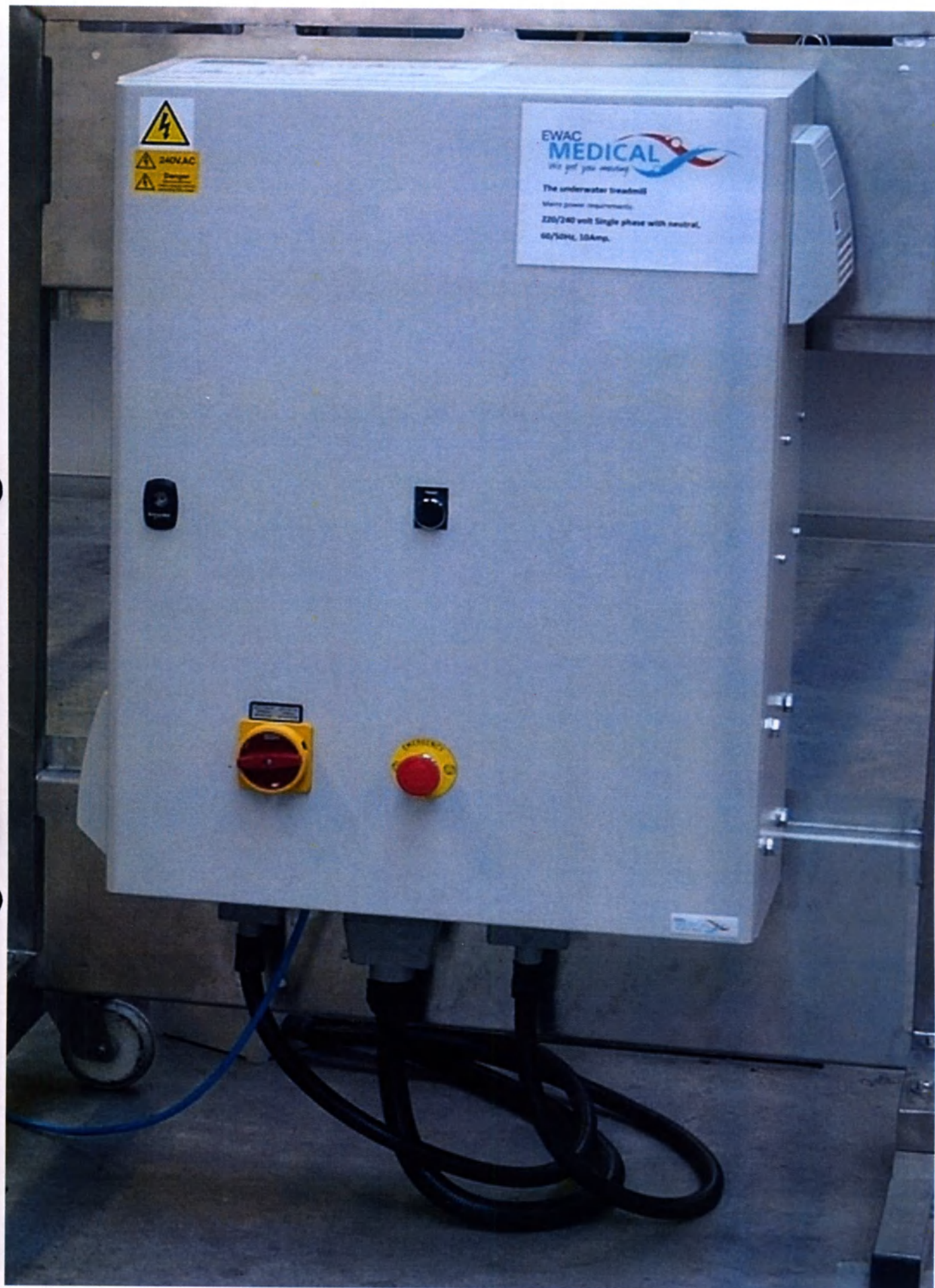
Трансформатор понижающий, размеры 63x48x27 см
