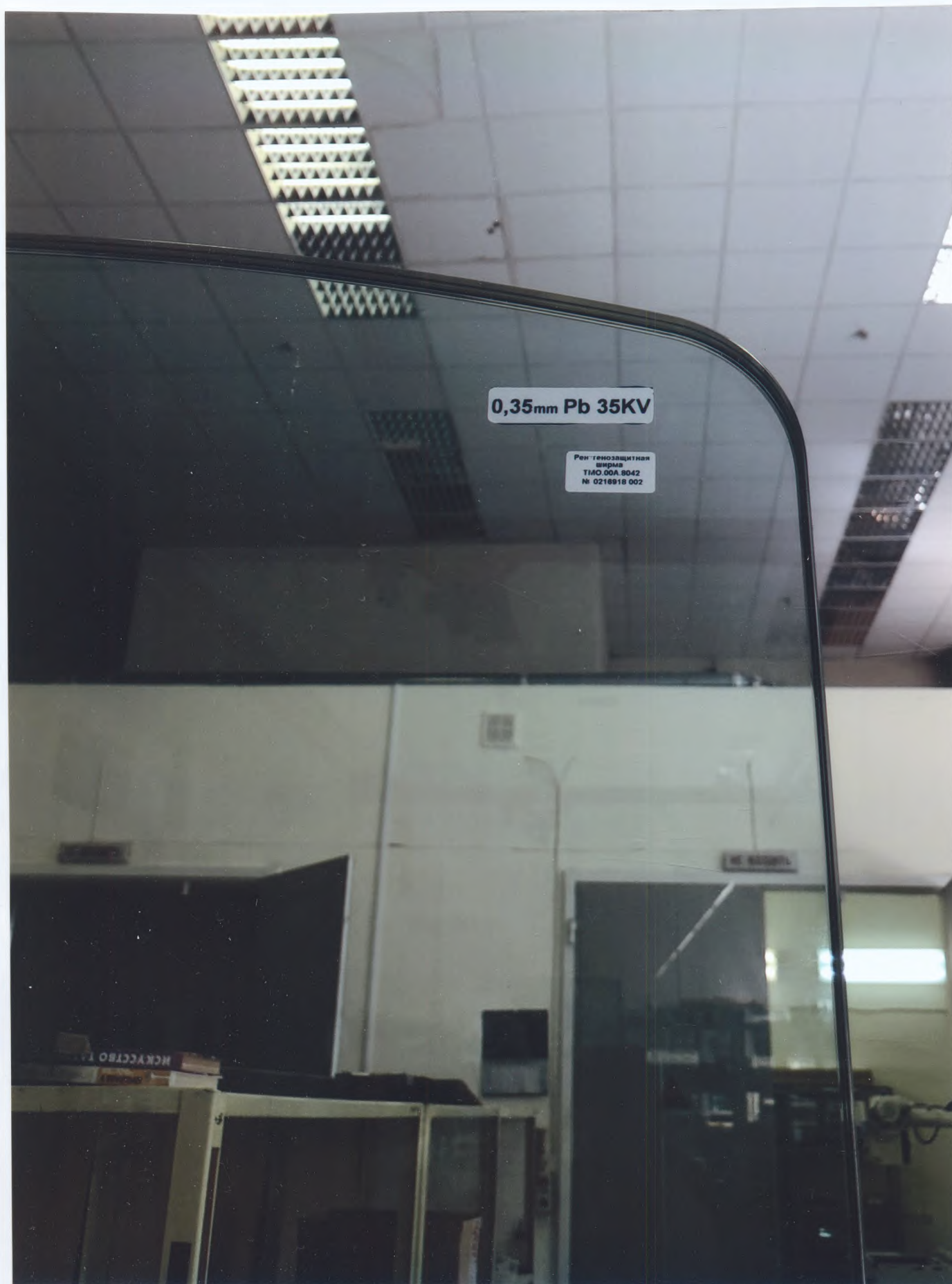
6. На фото представлена: Ширма рентгенозащитная ТМО.00А.8042 производства АО «НИИЭМ» или производства Metaltronica S.p.A, Италия
