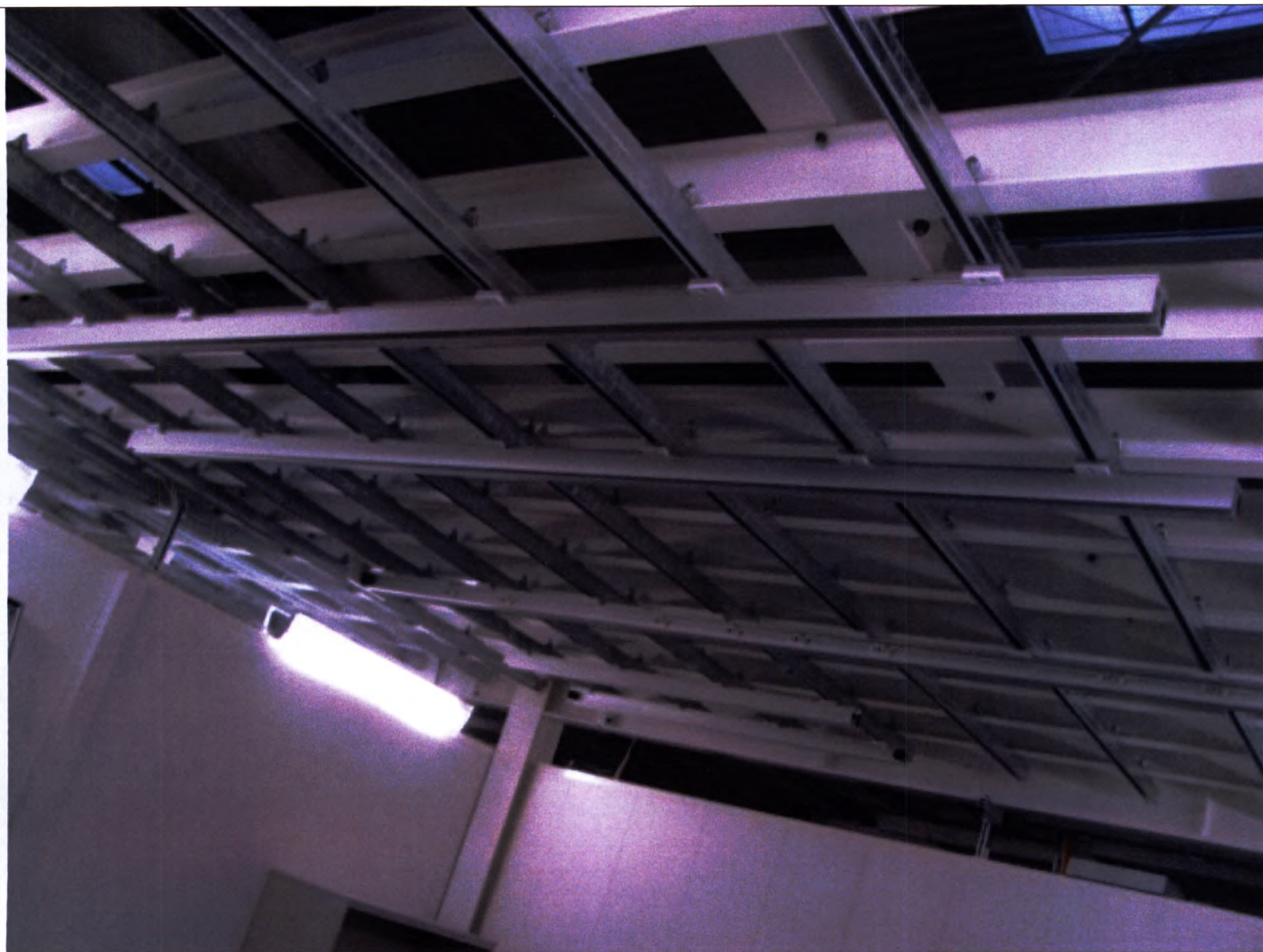
62. Крепление специальное для увеличения длины продольного перемещения
