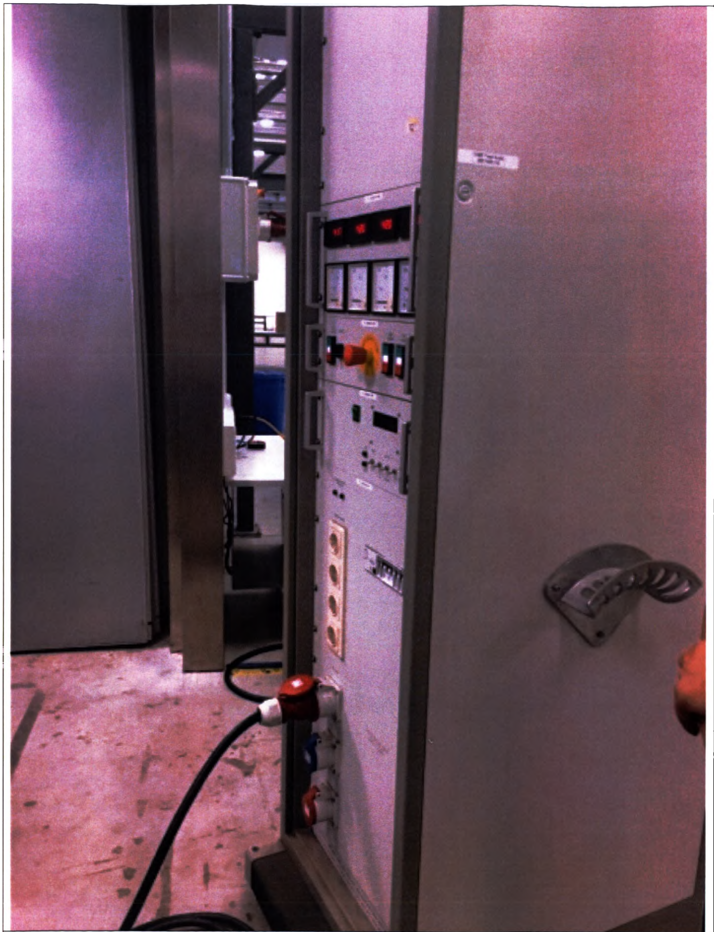
17. Сетевой распределитель в комплекте с рубильником общего включения и аварийными выключателями
