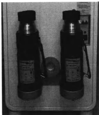
Рисунок 35: Полки для хранения сосудов Дьюара - правильный способ установки сосудов Дьюара в полки.
