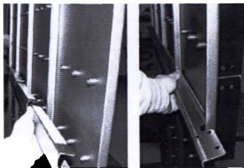
Рисунок 16. Расположение скобы задней и прикрепление ее к ДФД
