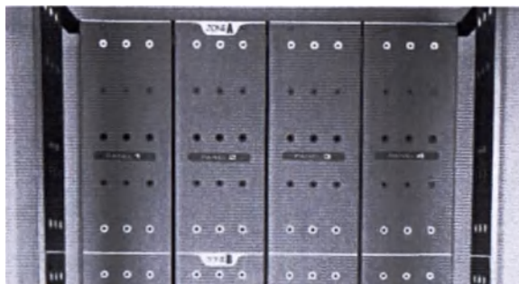
Рисунок 178. Компоненты и штифты коммутационная панели ДФД
