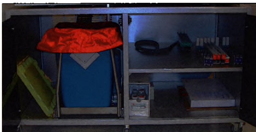
Рисунок 1.44: Внутреннее устройство шкафа-стеллажа
