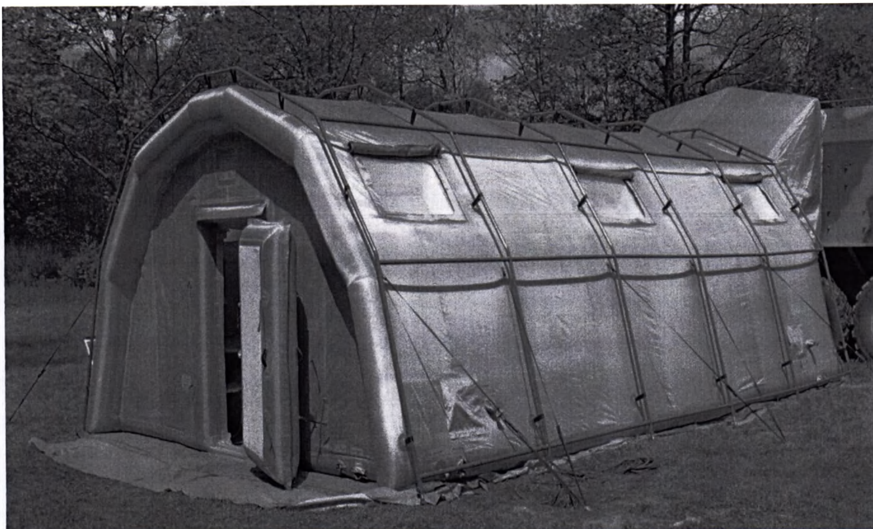
Фотография 4.1. Пневмокаркасный модуль: Быстровозводимое пневмокаркасное сооружение БВПС-АП для автоперевязочной.
