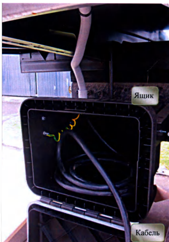
Рисунок 5 – Отсек силового кабеля
