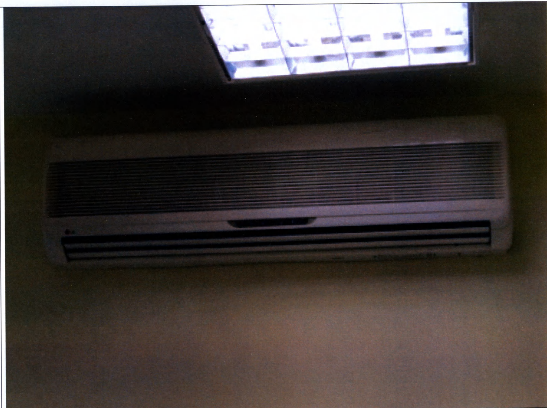
58. Система охлаждения/кондиционирования гентри.
