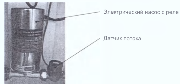
Рис.3 Электрический насос с реле и датчиком потока
