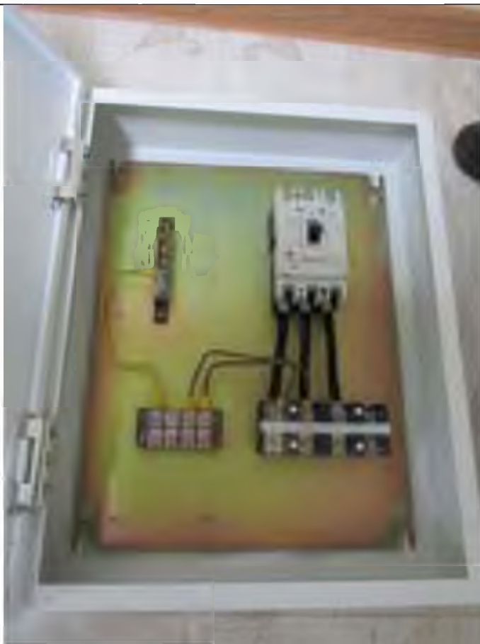
Рисунок А-36 Устройство электрораспределительного щита
