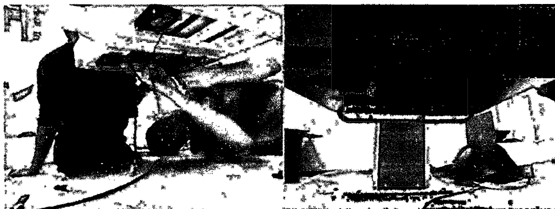
Рисунок 85 Установка нижнего кожуха детектора
