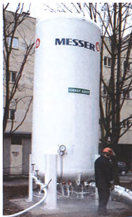
Rysunek 2.3 Zbiornik na ciekły azot zainstalowany u klienta
