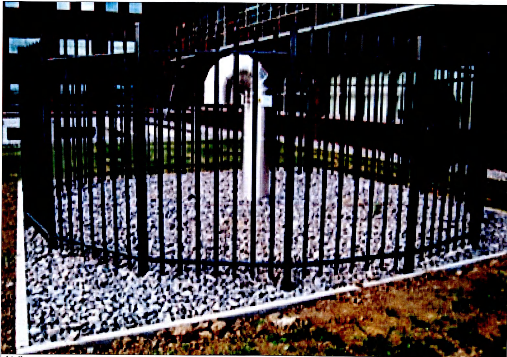
14. Система вытяжки гелия
