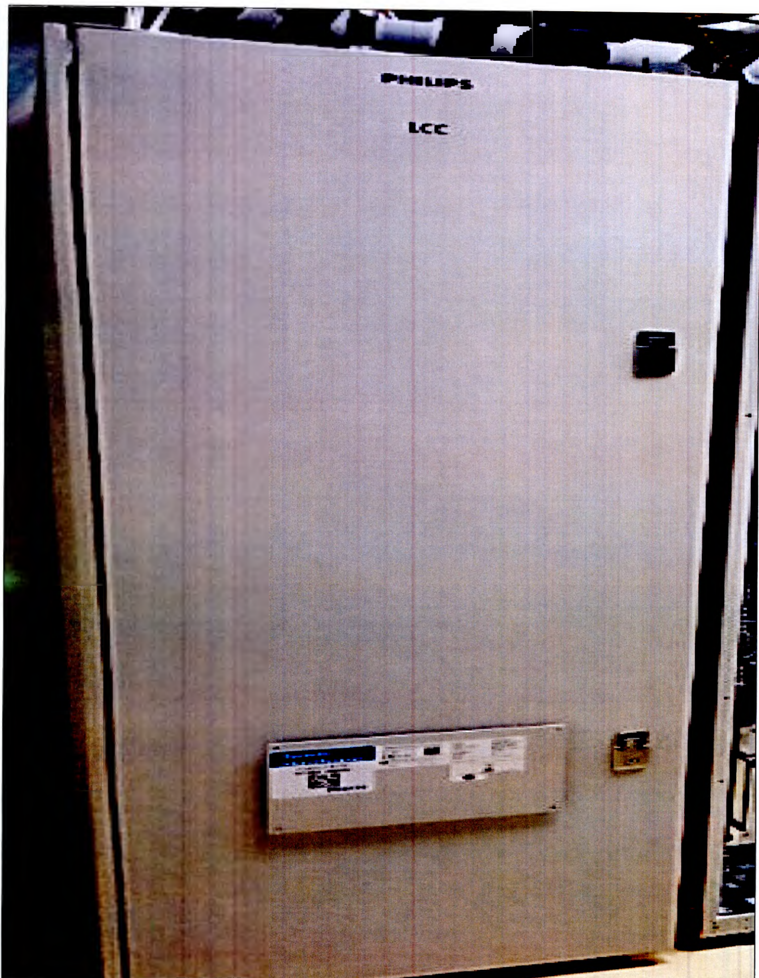
136. Система охлаждения с нулевым выкипанием гелия
