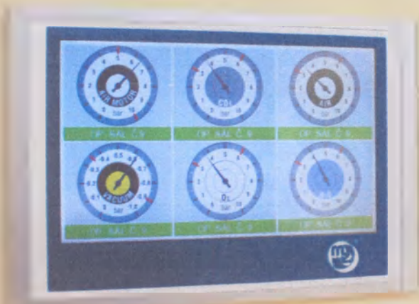
Оборудование для наблюдения и мониторинга давления в распределительных сетях медицинских газов: Устройство регистрации давления медицинских газов в системе центрального газоснабжения, варианты исполнения: MZU 010.094, MZU 010.095, MZU 010.096.
