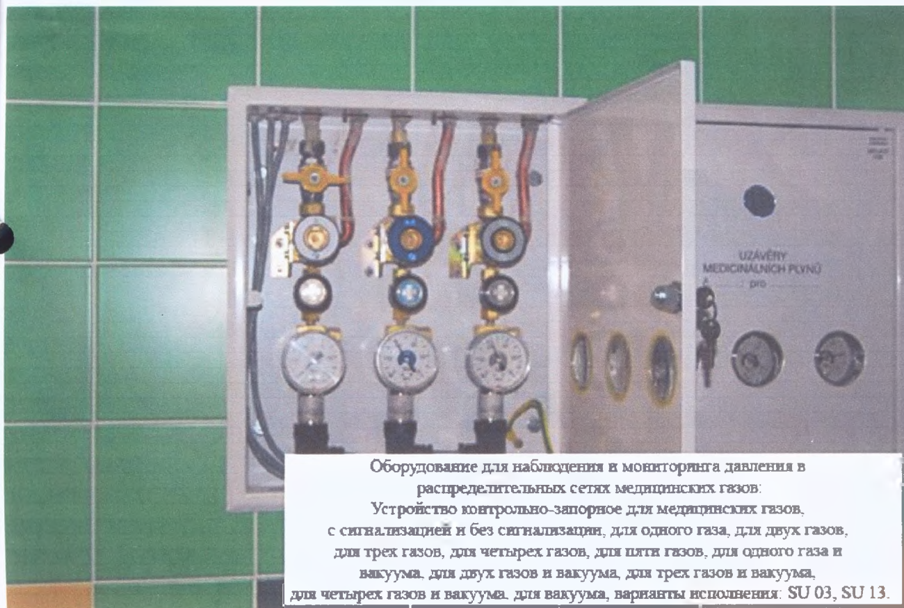
Оборудование для наблюдения и мониторинга давления в распределительных сетях медицинских газов: Устройство регистрации давления медицинских газов в системе центрального газоснабжения, варианты исполнения: MZU 010.094, MZU 010.095, MZU 010.096.
