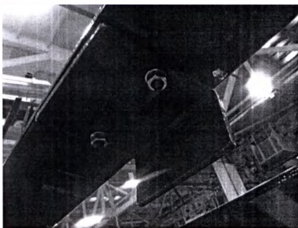
Фото 5, 6. Упор панели (демонтируется при снятии панели с рамы при ремонтах и т.п.).
