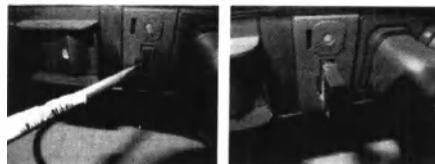
Рис. 14-1: Замена предохранителя на пульте управления
