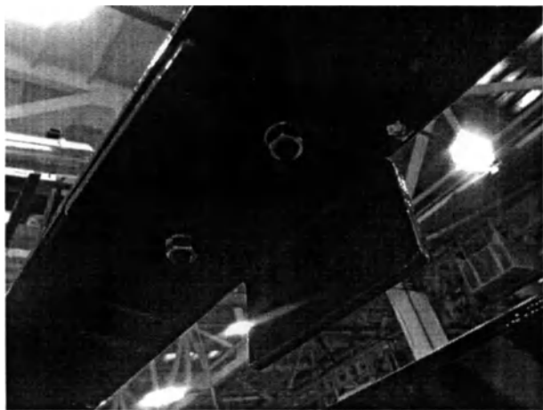
Фото 5, 6. Упор панели (демонтируется при снятии панели с рамы при ремонтах и т.п.).
