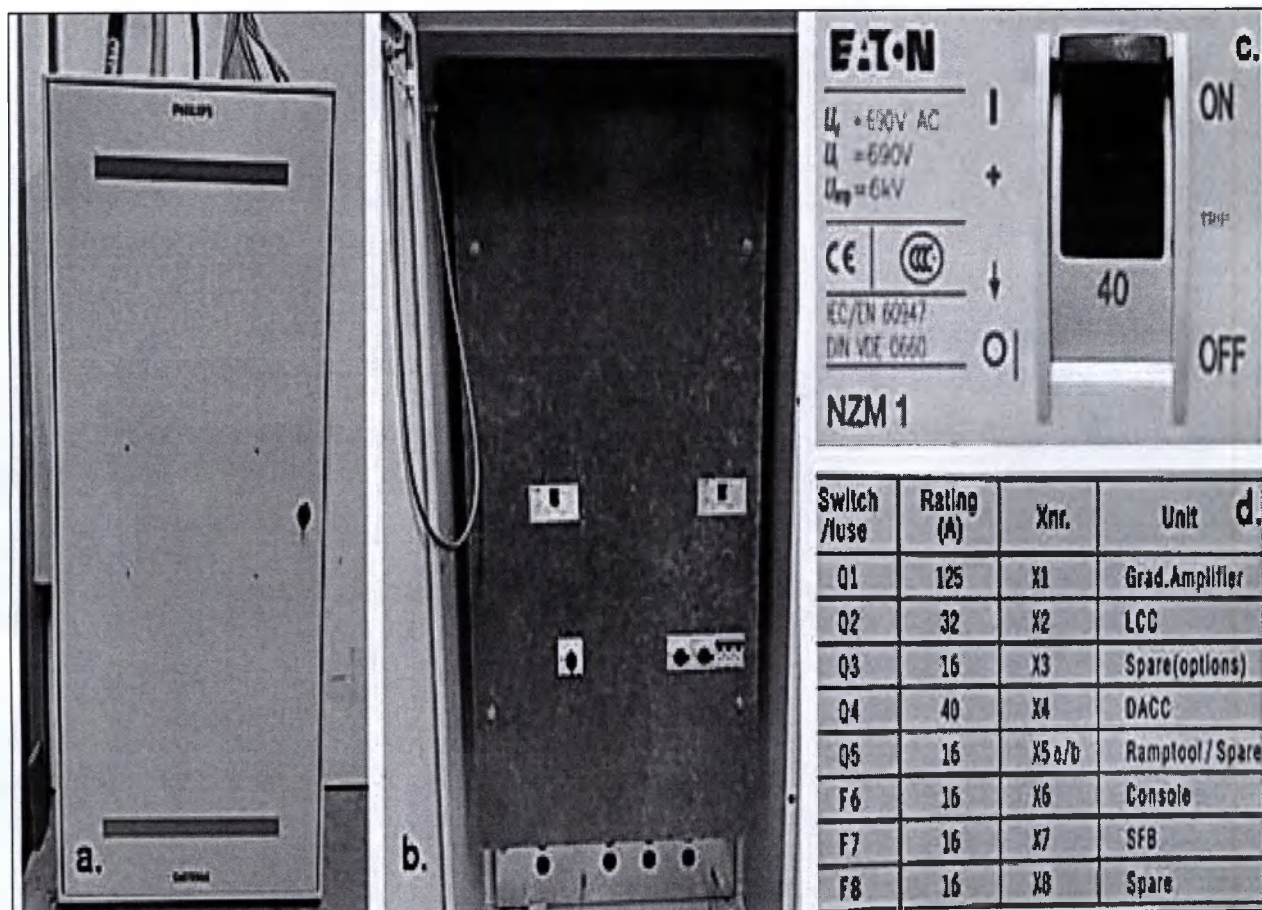
Рис.1: Примеры: (а) закрытого щита gMDU, (б) красной панели внутри щита gMDU, (с) переключателя DACC и (д) этикетки со служебными клавишами.
