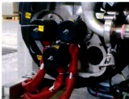
Рисунок 69 – Проверка и замена уплотнителя
