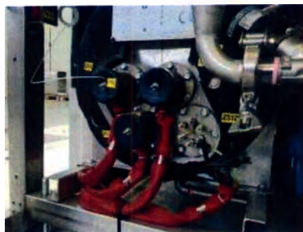
Рисунок 67 – Проверка и замена уплотнителя
