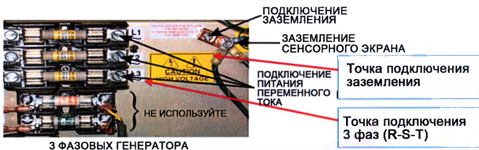
Рисунок 3-85. Подключение питания СПИ
