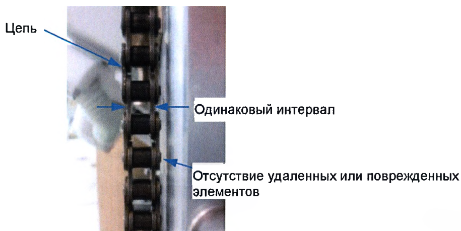
Рисунок 3-18. Проверка цепи на наличие повреждений
