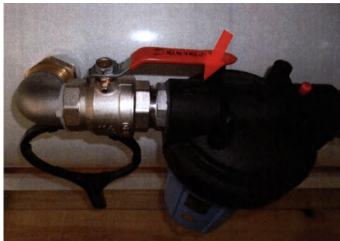
Рисунок 13 – Обозначение направления потока вакуума на бактериальном фильтре.
