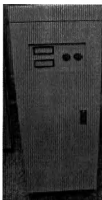
Рис. 2-19 Источник бесперебойного питания (стабилизатор напряжения)
