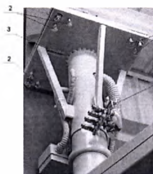
Рис. 2 Расположение органов регулировки и вентилях запираания подачи медгазов
