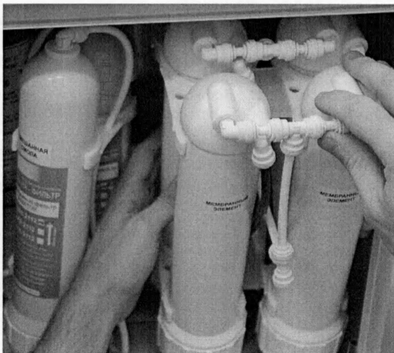
Фото 15. Извлечение мембранного блока
