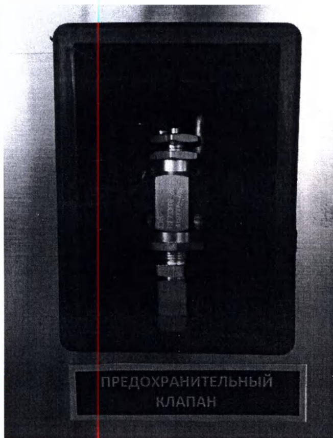
Предохранительный клапан
