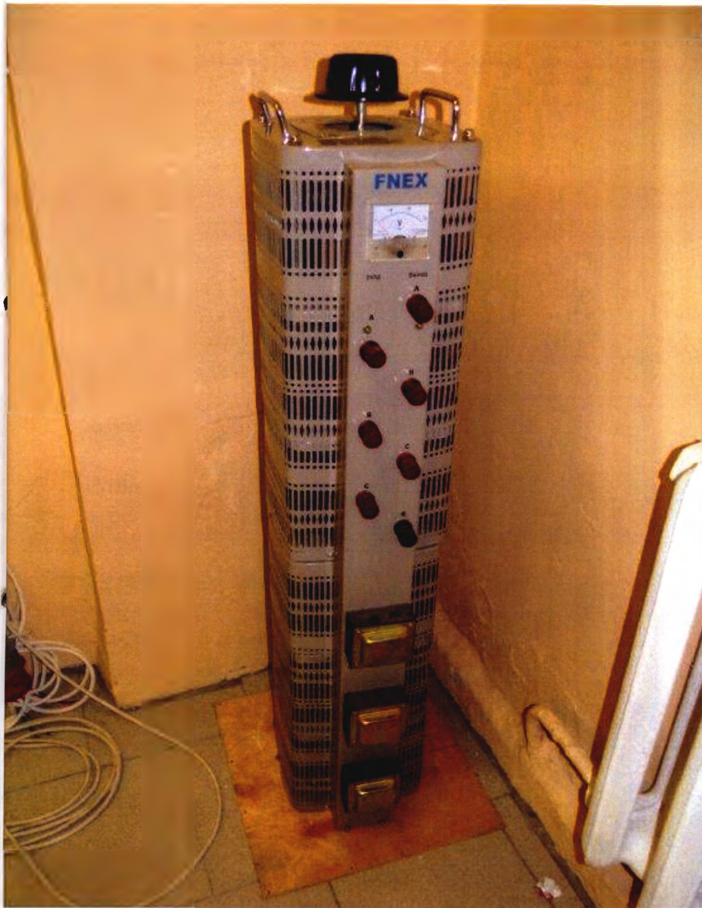
Стабилизатор напряжения трехфазный номинальное напряжение 380В с отклонениями напряжения не более \pm 3\% и мощностью не менее 50кВА) О «Научно-производственное предприятие «ИНТЕПС» ЗАО «ПФ«Созвездие» ЗАО «Тэксис-Техно»
