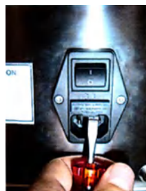
Рисунок 25. Замена основных предохранителей
