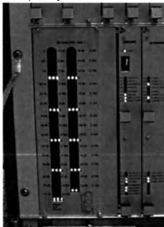
Рис. 86. Предохранители постоянного тока
