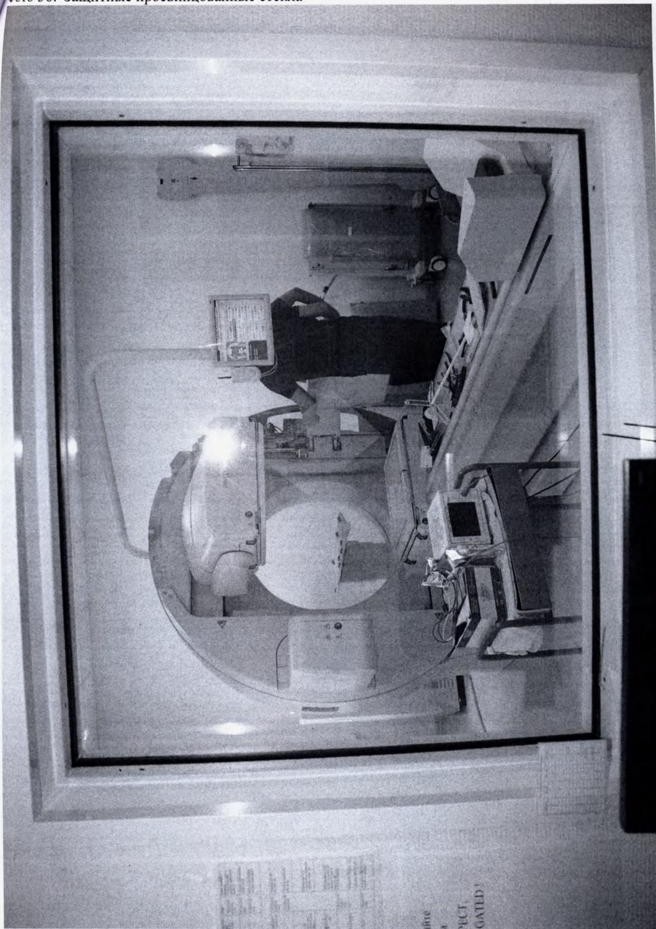
Фото 36. Защитные просвинцованные стекла
