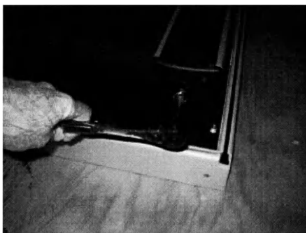
Иллюстрация 16: Регулировка траектории движения беговой дорожки или ее натяжение
