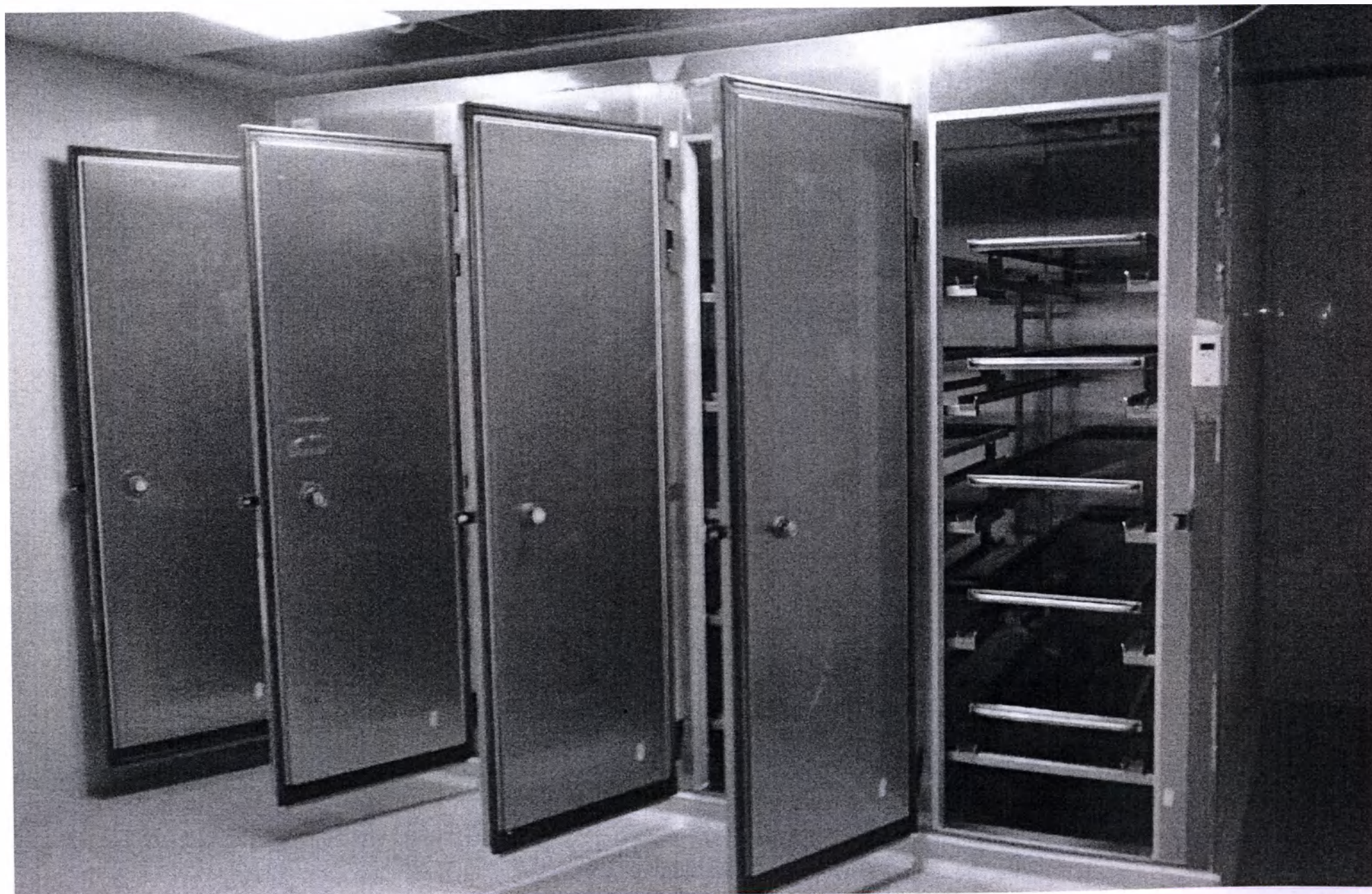
16. Холодильная камера для хранения трупов «Tanartis» на 25 мест, состоящая из пяти блоков с общей дверью на каждый блок; из нержавеющей стали.
