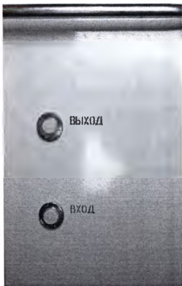
Рисунок 19. Штуцеры для подключения трубопроводов
